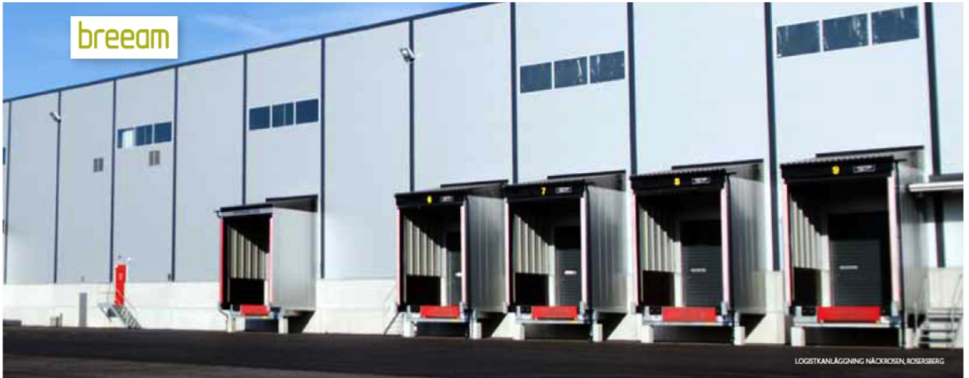
Maskrosen Logistikanläggning, Rosersberg © NCC Construction Sverige
