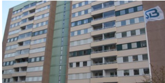
Sibeliushuset 2 efter ombyggnad © Miljöförvaltningen i Stockholm
