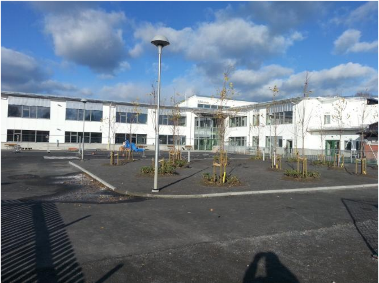
Vega skolan från söder sidan med delar av skolgården © Thomas Greindl, Sweco Architects
