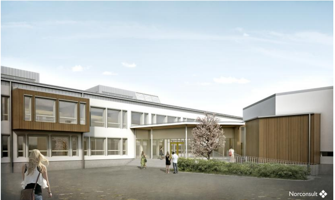
Vy mot entré. © Norconsult AB
